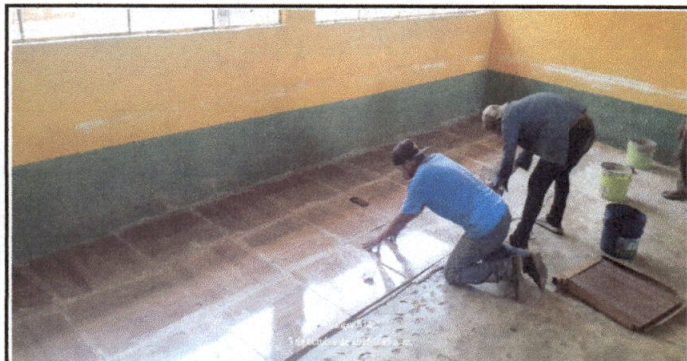
Foto 6: Avance de colocacion de pisos ceramico
