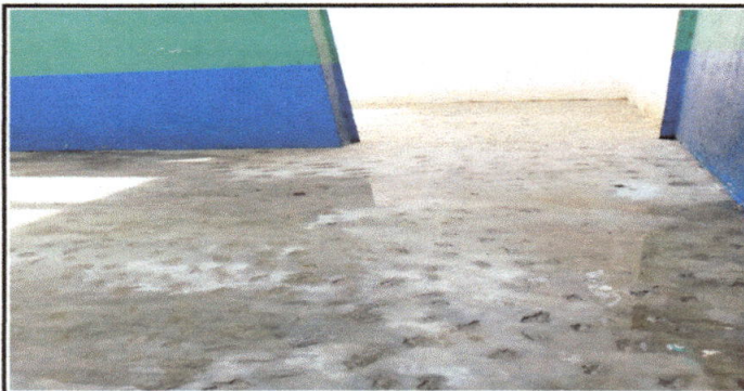
Foto 6: Proceso de nivelacion de entortado para la instalacion de piso ceramico
