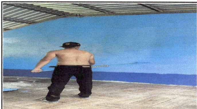
Foto 4: se indentifica el avance de la aplicación de pintura en el interior del establecimiento
