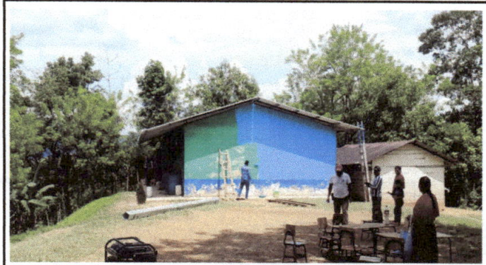
Foto 2: como se muestra en la fotografia el avance de la aplicación de pintura
