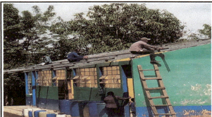
Foto 3: Se observa el avance de la aplicacion pintura
